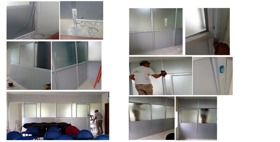
❖ Servicio De Suministro E Instalación De Mampara De Aluminio Y Vidrio E Instalación De Película
