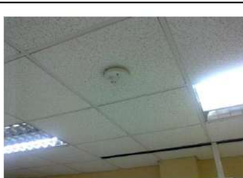
TIPO DE DETECTOR DE HUMO EXISTENTE
