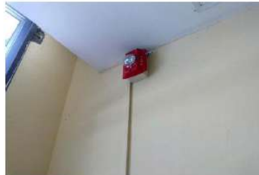
TIPO DE LUZ ESTREBOSCÓPICA EXISTENTE
