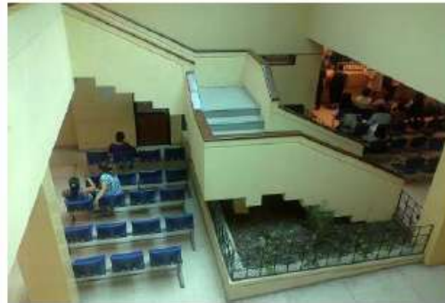
TIPO DE GRADAS ENTRE LOS DOS NIVELES DEL CENTRO DE ATENCIÓN
