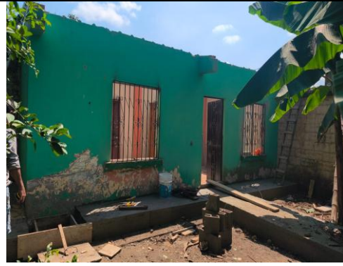
Adecuación de nueva bodega en la agencia IESS
