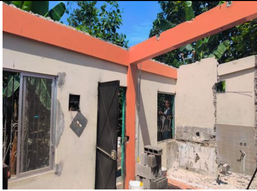
Adecuación de nueva bodega en la agencia IESS
