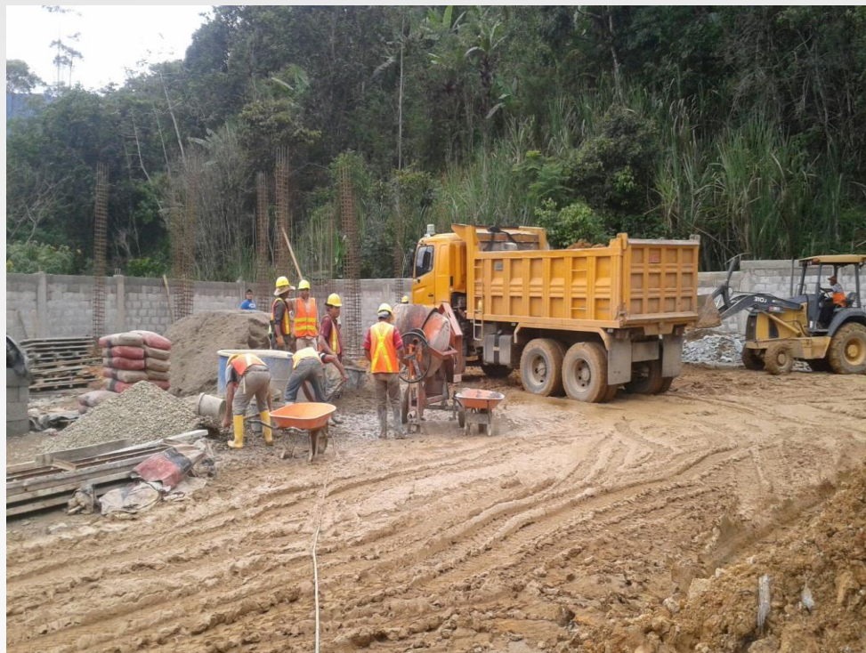
Construcción del Nuevo Dispensario Tipo A1 en Milagro 2, cantón Atahualpa, por un monto de $ 482,919.76
