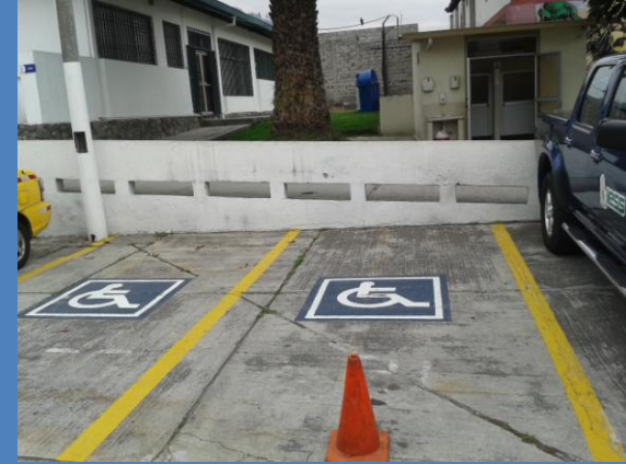
Parqueaderos preferenciales debidamente identificados
