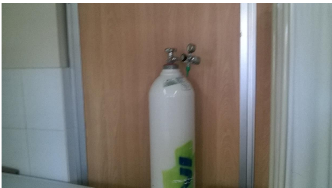
Fotografía Nro. 4 : Tanque de oxígeno sin anclaje
