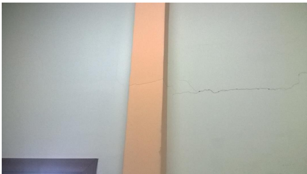
Fotografía Nro. 2: Fisura presentada al interior del centro médico
