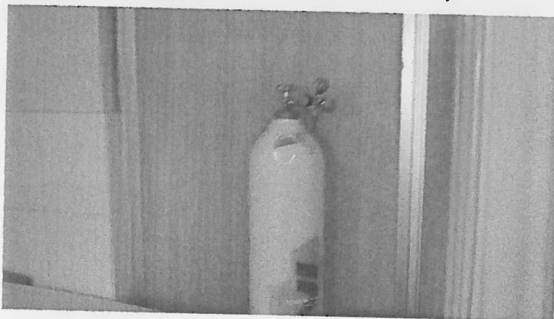
Fotografía Nro. 4 : Tanque de oxígeno sin anclaje
