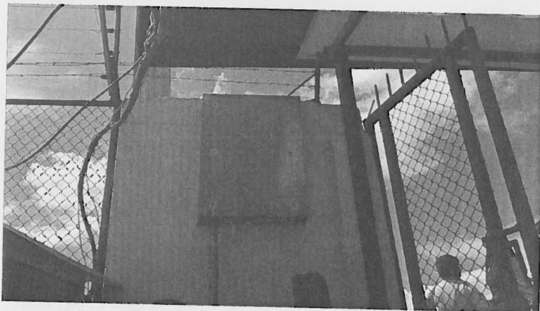
Fotografía Nro. 4 : Tanque de oxígeno sin anclaje
