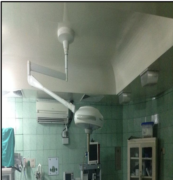
Reemplazo de Lámpara Cielitica e Instalación de Nuevas Lámparas en los Quirófanos del Hospital General de Machala
