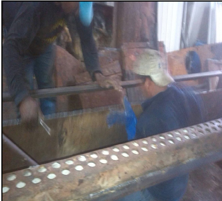
Intervención en el sistema de vapor generado por los Calderos del Hospital General de Machala
