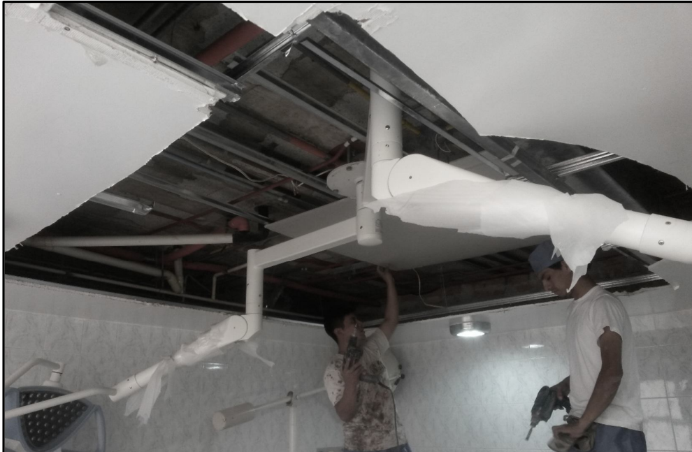
Ampliación del área de trabajo de las Lámparas Cielíticas, en el tumbado de los Quirófanos para el movimiento de los brazos de las lámparas en cada cirugía, conforme lo requiera el especialista.
