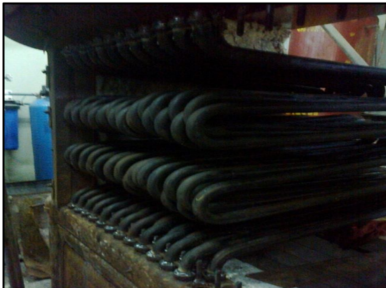
Intervención en el sistema de vapor generado por los Calderos del Hospital General de Machala
