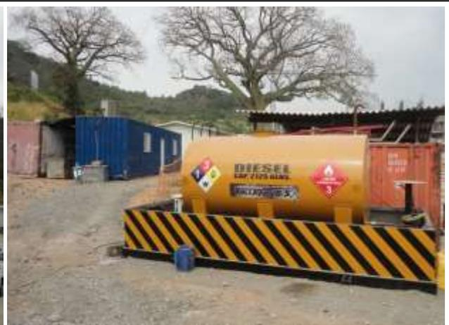
**Foto No. 2.** Tanque de almacenamiento de combustible
