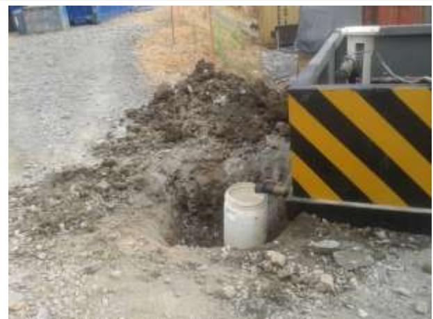
**Foto No. 10.** Cubeto de contingente en el tanque de almacenamiento de combustible de 2125Gls.
