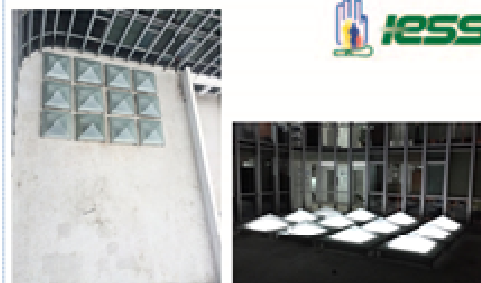
TERRAZAS DESPUÉS: IMPERMEABILIZACIÓN, COLOCACIÓN DE CLARABOYAS
